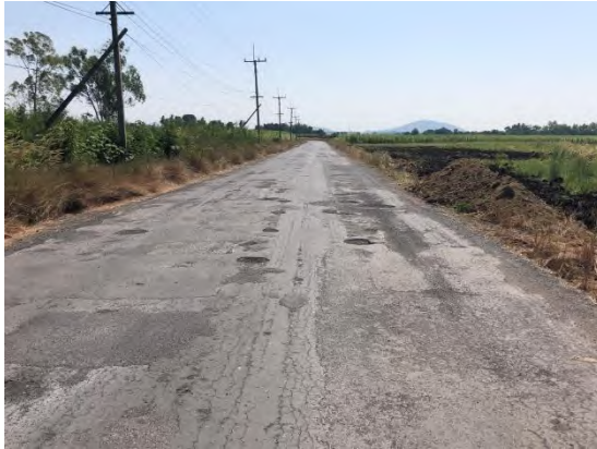
สภาพถนนก่อนดำเนินการ
