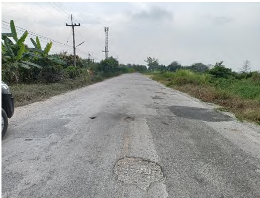
สภาพถนนก่อนดำเนินโครงการ
