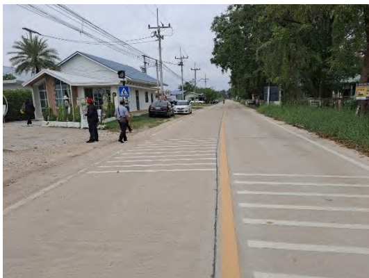
การติดตั้งสัญญาณไฟกระพริบและป้ายเตือน
