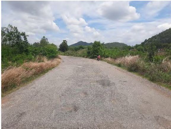
สภาพถนนก่อนดำเนินโครงการ
