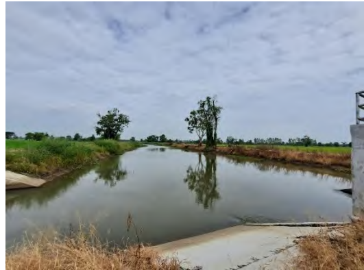
สภาพหลังดำเนินโครงการ
