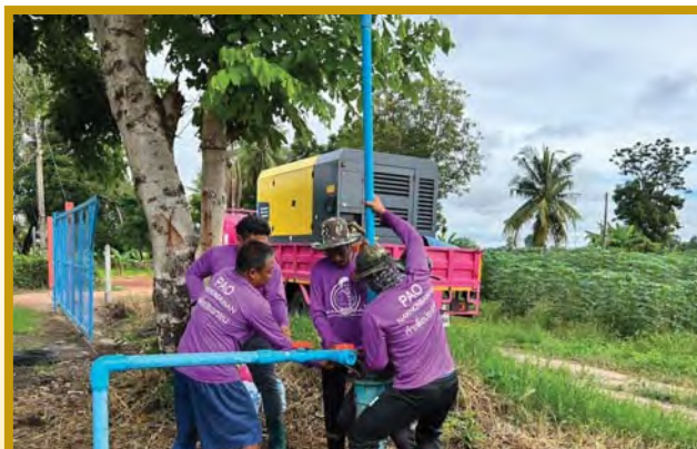
ภาพที่ ๔ แสดงการปฏิบัติงานเป่าล้างบ่อน้ำบาดาล
