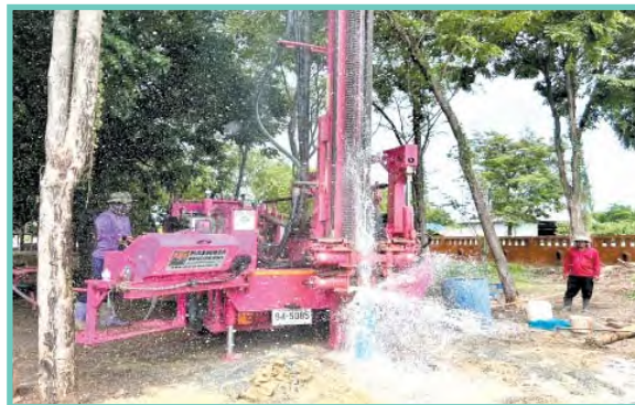
ภาพที่ ๒ แสดงการปฏิบัติงานขุดเจาะบ่อน้ำบาดาล
